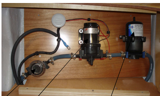
Filter Wasseranlage 12V
