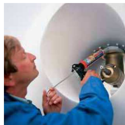
Étanchéité du propulseur d'étrave
