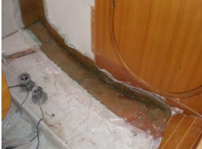
Figure 8 la première couche de mat a été posée sur la choucroute qui assura maintenant la liaison cloison - coque
