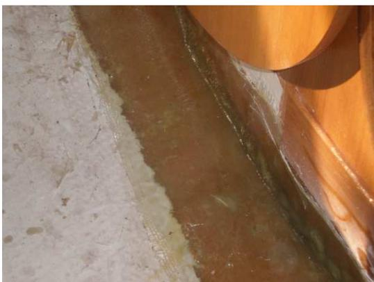
Figure 9 La stratification est finie
