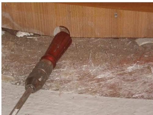
Figure 3 : La cloison ne repose pas sur la coque !!
